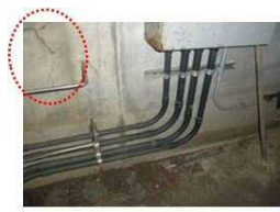
写真1：地下ピット内部
