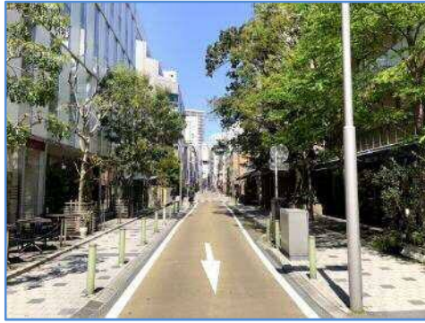
(写真 2 - 2) 道路幅員の再構成による地上機器の設置状況
