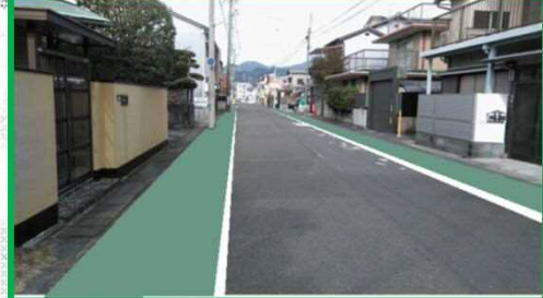
グリーンベルトの設置 (側溝工事後対応予定)
