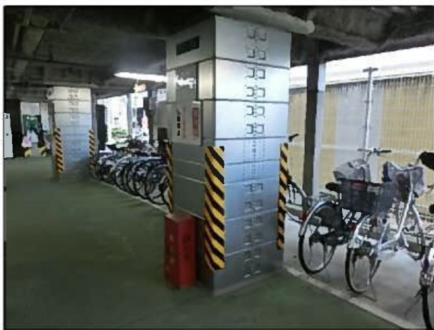
写真 11 黒金町西第 1 駐輪場耐震工事
