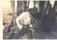
上部リベット打ち (写真提供:三井住友建設株)
