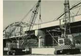
歩道橋設置工事 (写真提供:市川土木株)
