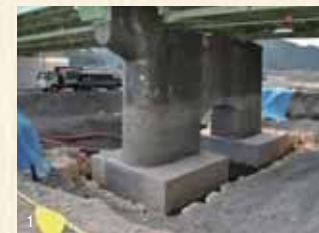
コンクリート巻き立てによる橋脚補強 1.施工前 2.施工後
