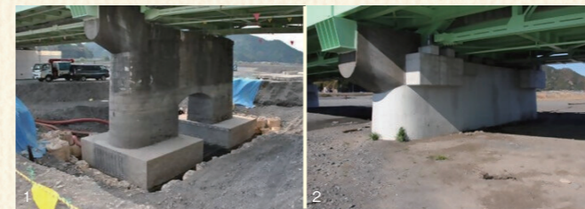
コンクリート巻き立てによる橋脚補強 1.施工前 2.施工後
