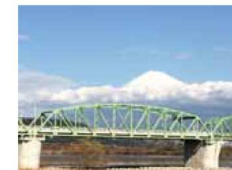
富士川橋（1924年完成）
