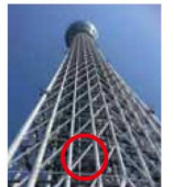
「東京スカイツリー」にもトラス構造が使われています。
