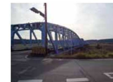
大井川橋（1928年完成）
