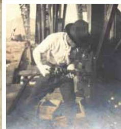
建設当時のリベット作業の様子 写真提供：三井住友建設（株）
