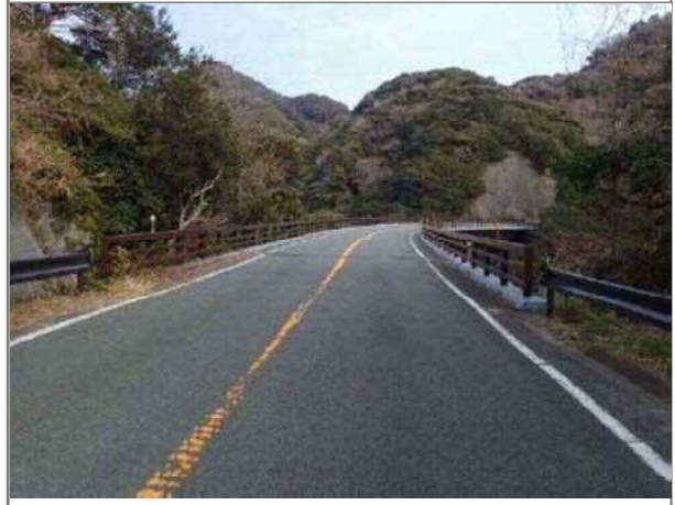
写真-4 : 路面正面
