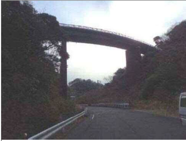
写真-1 : 側面全景
