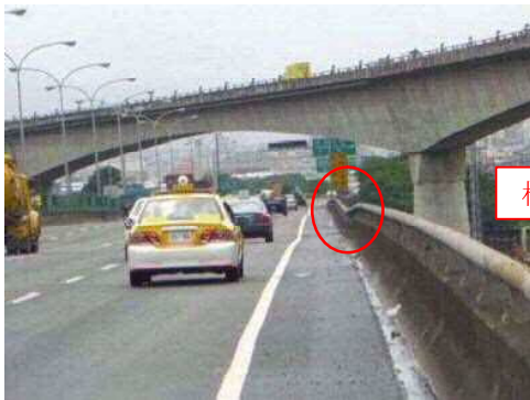
PC橋の中央ヒンジ部が垂れ下がっている状態
