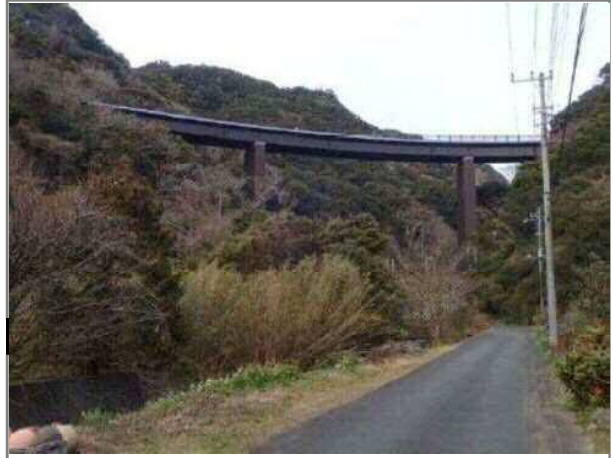
写真-2 : 側面全景
