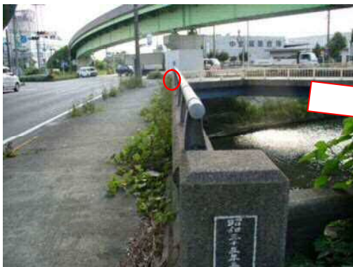
中間支点の掛け違い桁で平面的なずれが生じている例
