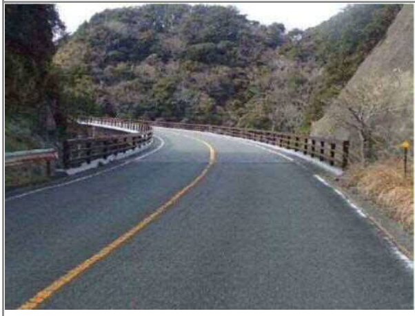
写真-3 : 路面正面
