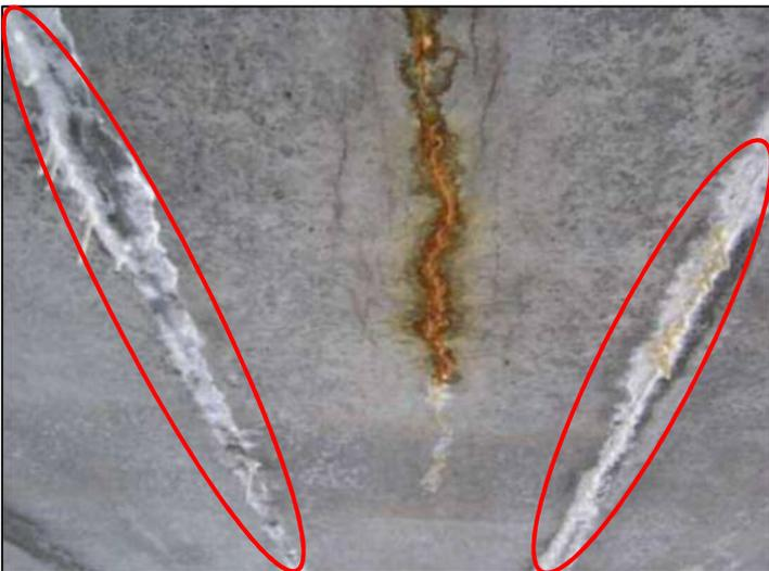
\*うき、<sup>はくり</sup>剥離：コンクリートが浮いて空洞ができていること、剥がれ落ちること
