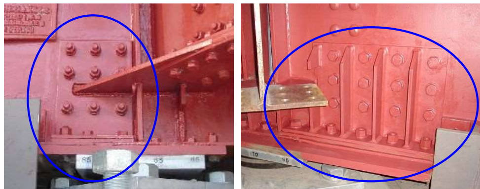
写真-5.2.3 あて板補強の実施例
