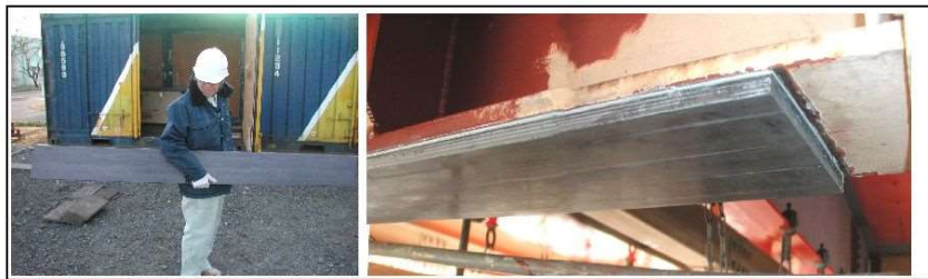
図-7.2.2 連続繊維板接着工法の例
