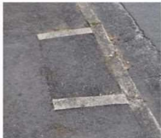
アスファルト舗装
