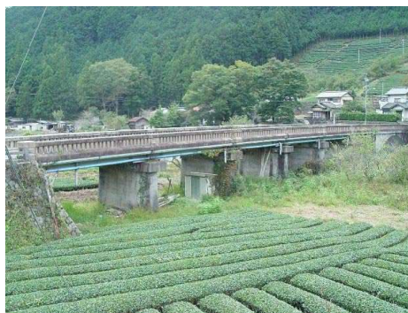
写真 1.1 建設後 80 年を超え良好に使われる橋（長熊橋 昭和 5 年架設）
