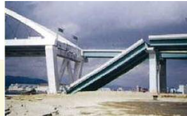
橋桁の一部が落橋(1995年 阪神・淡路大震災)
