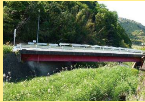
単径間の橋(油山橋)
