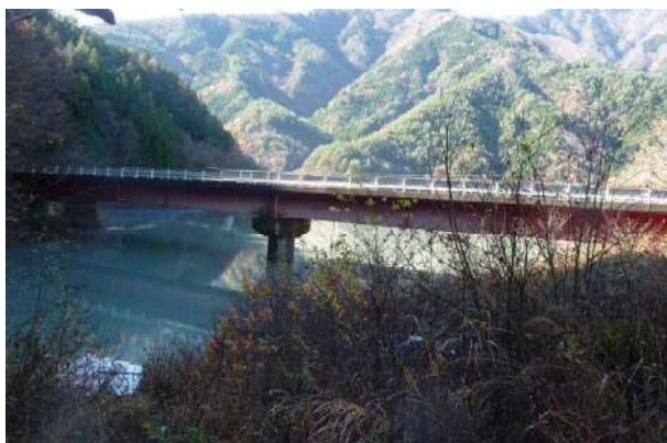
所沢橋2(孤立集落対策路線)
