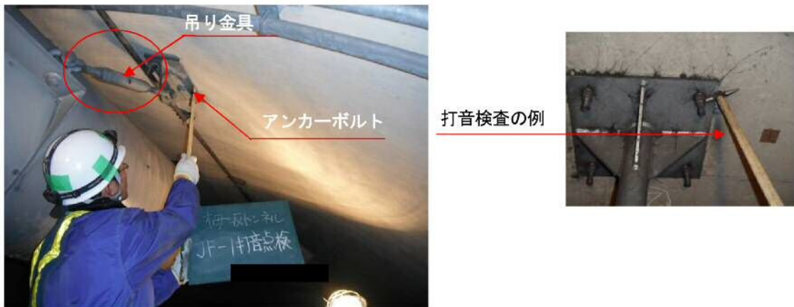
図-5.3 打音検査作業状況
