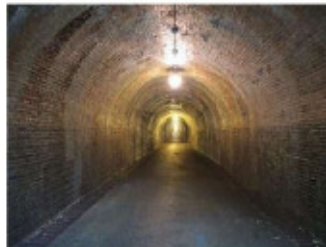
写真-1.2 宇津ノ谷トンネル (レンガ積み構造)
