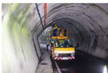
写真-1.1 金山トンネル (素掘り、吹付コンクリート構造)
