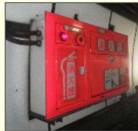
写真 消火設備設置状況
