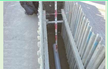
下水道管布設（開削工法）
