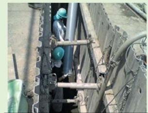
下水道管布設工事の様子
