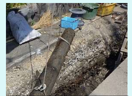
老朽化した水道管 の布設替えの様子
