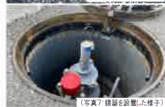
写真7 機器を設置した様子
