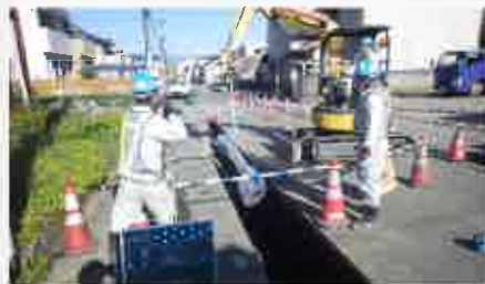
(写真3:水道管更新工事施工状況)
