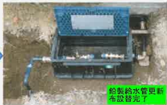
(写真1:鉛製給水管更新修繕)
