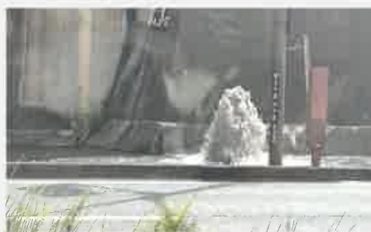
(写真1:漏水状況 清水区吉川地内(国道1号)(令和元年9月))
