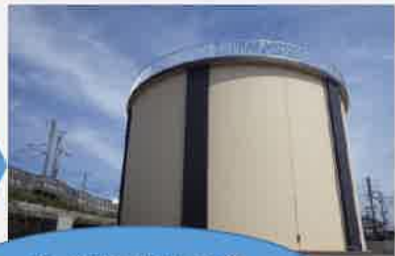
(写真3:新しい配水池)
