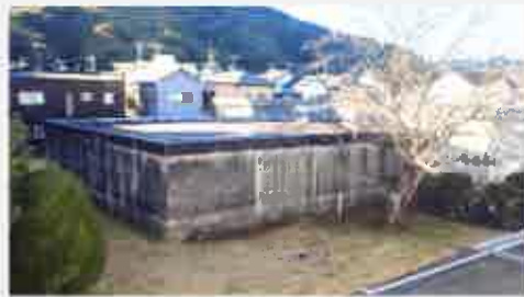
(写真1: 既設配水池)
