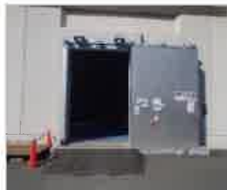
(写真4:防水扉の設置)
