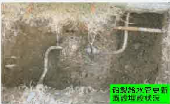
(写真1:鉛製給水管更新修繕)
