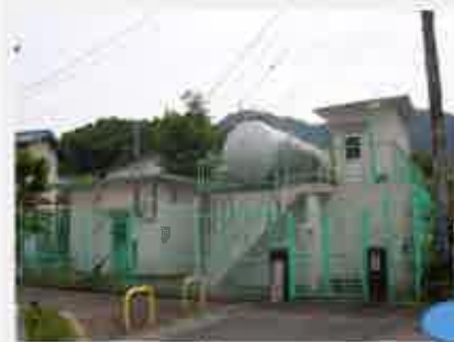
(写真2:小規模な加圧施設)
