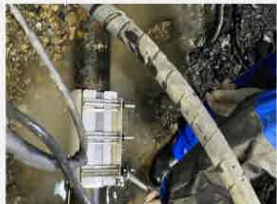
(写真5: 修繕後の様子)
