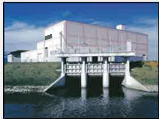
(写真2:雨水ポンプ場)
