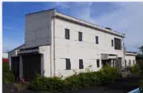
(写真1:宮加三ポンプ(廃止予定))
