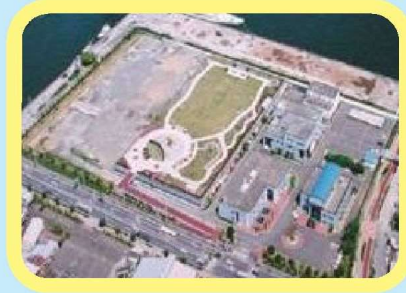
せいせいじょうか 静岡浄化センター (静岡処理区)
