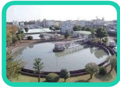
たかまつじょうか 高松浄化センター (高松処理区)
