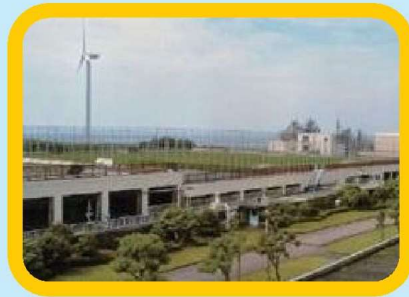
なかしまじょうか 中島浄化センター (中島処理区)
