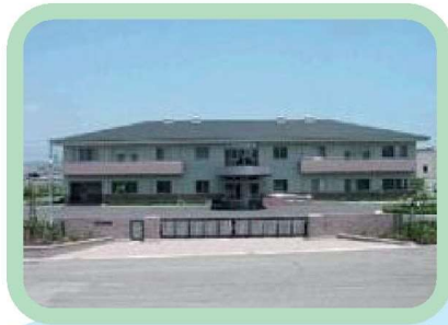
おさだじょうか 長田浄化センター (長田処理区)
