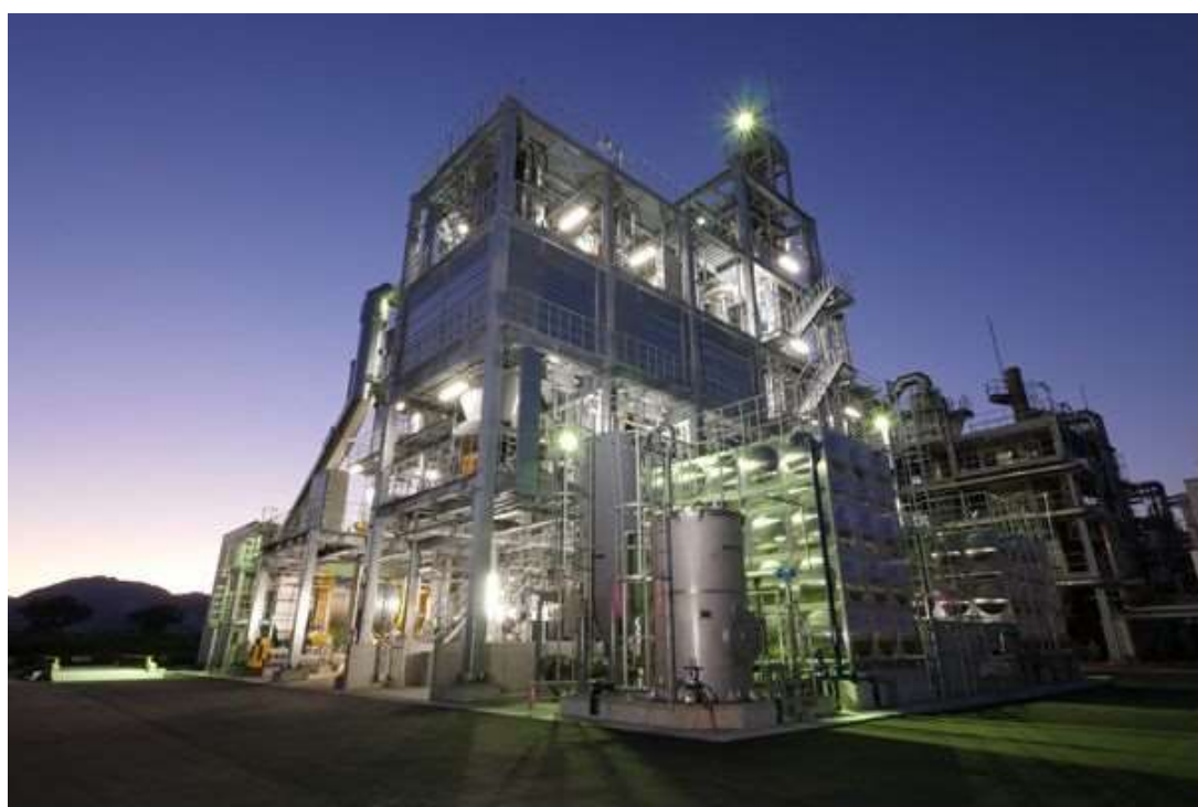
中島浄化センター汚泥燃料化施設
