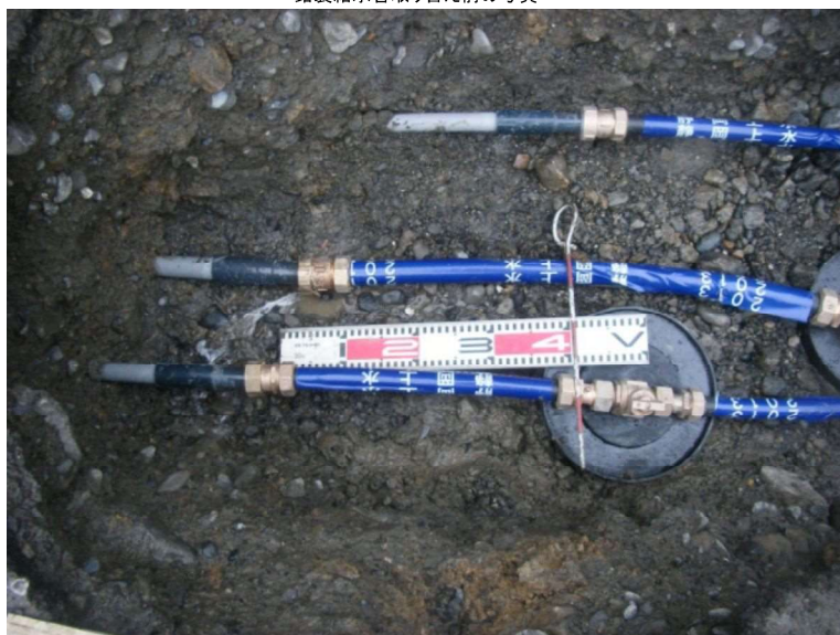
鉛製給水管取り替え後の写真
