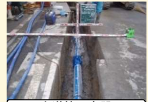
水道管の布設
