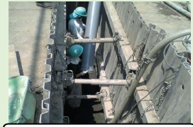
下水道管の整備
