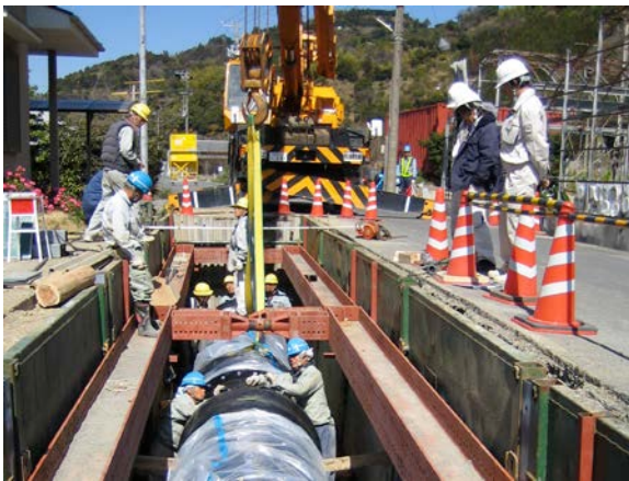
老朽管布設替工事状況
