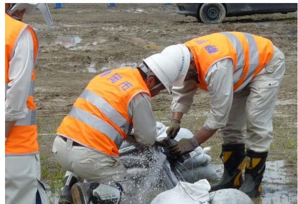
大規模津波防災総合訓練での漏水修繕実地研修の様子
