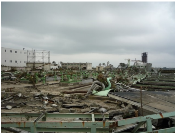
津波による浄化センターの被害状況
