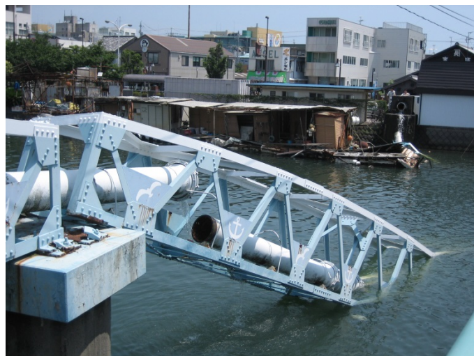
図 3-6 老朽化し破損した水道管
