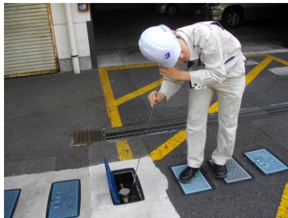
図 5-4 漏水調査の様子
