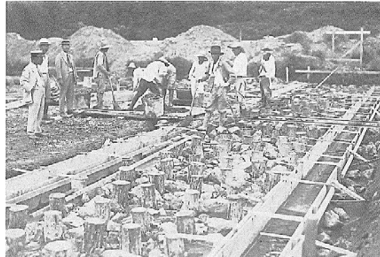
図 2-1 当初の門屋浄水場緩速ろ過池工事風景
