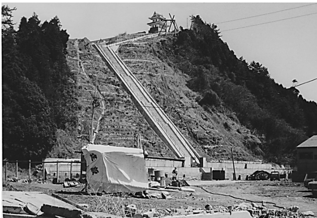
図 2-2 大平山配水池築造工事風景(昭和 42 年頃)
