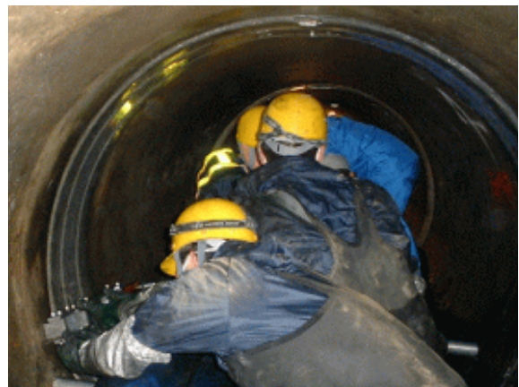
下水道管の耐震継手設置状況
