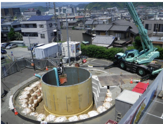
非常用耐震性貯水槽工事状況
