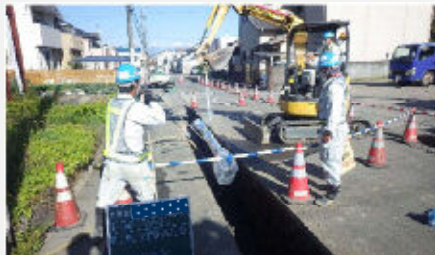
(写真3: 水道管更新工事施工状況)
