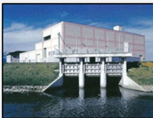
(写真2:雨水ポンプ場*)
