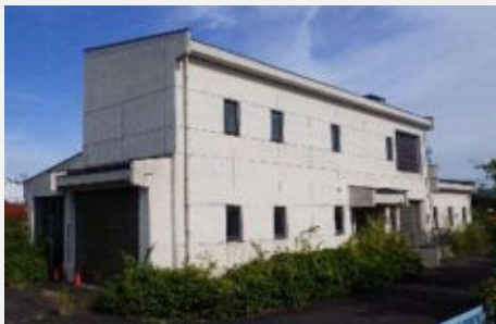
(写真1:宮加三ポンプ(廃止予定))
