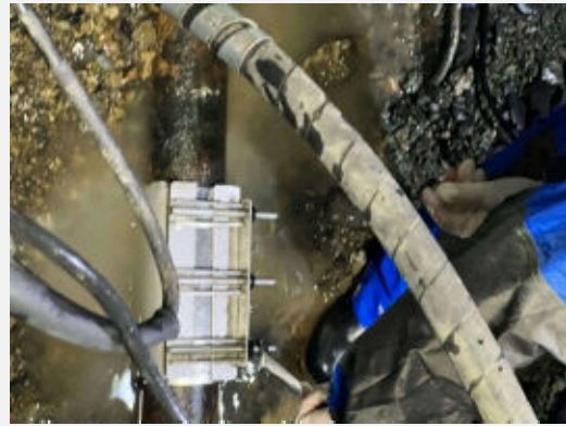
(写真5:修繕後の様子)
