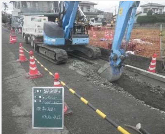
(写真1:道路掘削) 管を入れるため道路を掘っています
