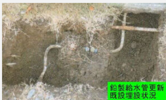
(写真1:鉛製給水管更新修繕)
