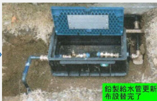
(写真1:鉛製給水管更新修繕)
