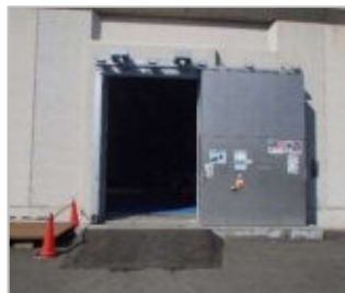
(写真4:防水扉の設置)
