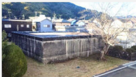
(写真1: 既設配水池)
