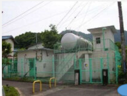
(写真2:小規模な加圧施設)
