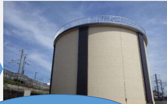
(写真3:新しい配水池)
