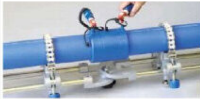
水道配水用ポリエチレン管(HPPE) 接合状況
