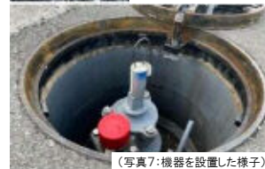
(写真7:機器を設置した様子)
