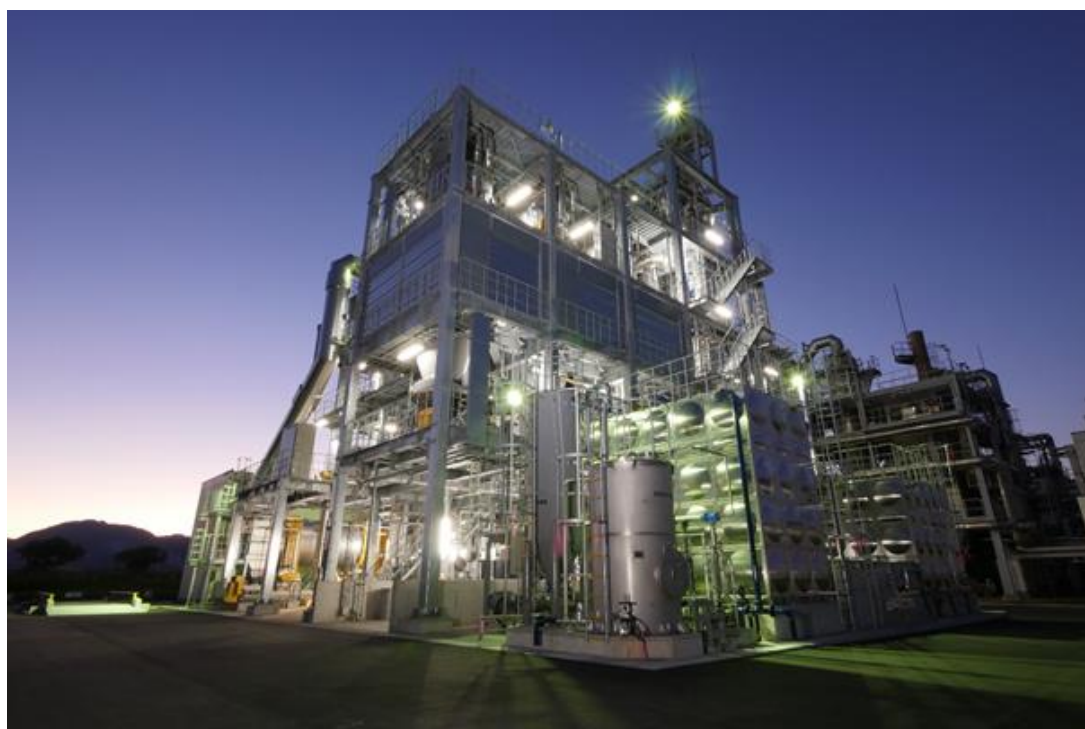
中島浄化センター汚泥燃料化施設
