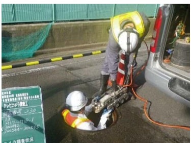
【下水道管のカメラ調査】
