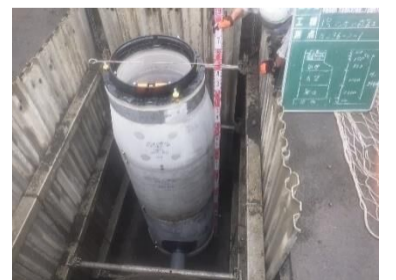
【マンホールの設置】
