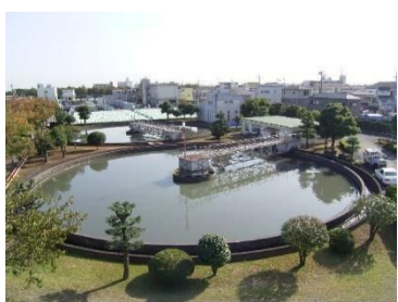
【高松浄化センター 最初沈殿池】
