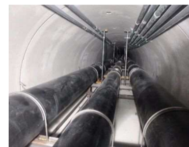
【直径2.6mのトンネルの中に3本の水道管を挿入】
