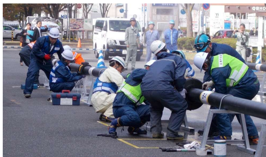
【応急復旧訓練】
