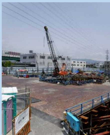
工事現場の様子
