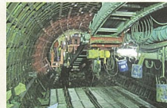
工事中のトンネル内(先頭付近)
