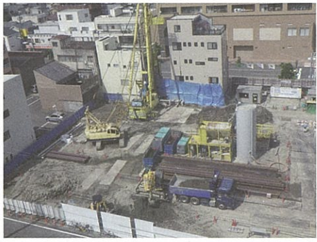
6月～10月 地面の掘削を主に行いました。大きな石などの地中の障害物を撤去しながら掘削し、地下1階を作るための空間を作っていきます。
