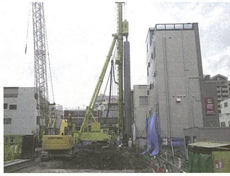
6月～10月 地面の掘削を主に行いました。大きな石などの地中の障害物を撤去しながら掘削し、地下1階を作るための空間を作っていきます。
