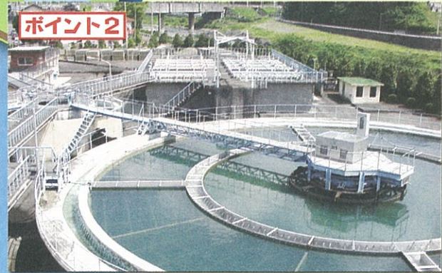
谷津浄水場 やつじょうすいじょう
