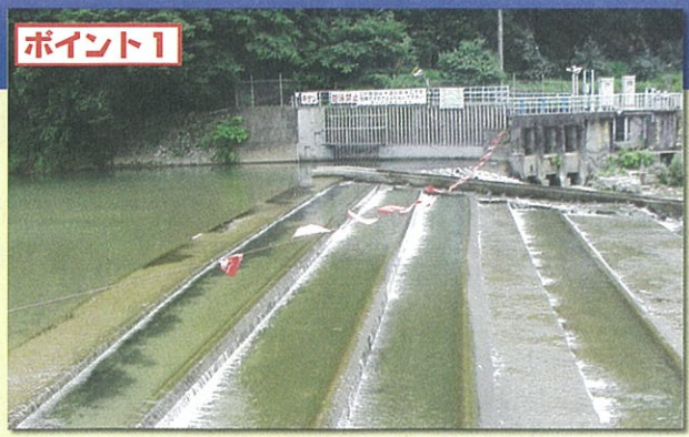
承元寺取水口 しょうげんじしゅすいこう
