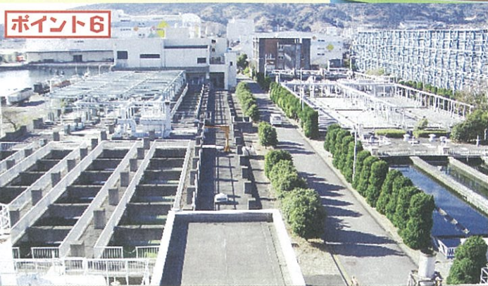
清水南部浄化センター しみずなんぶじょうかせんたー
