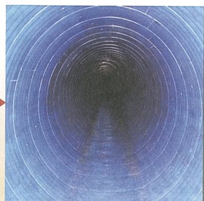
【污水管補強後】
