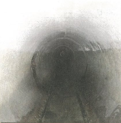
【污水管補強前】
