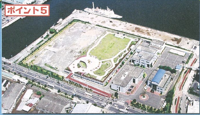
静清浄化センター せいせいじょうかせんたー
