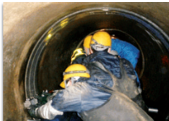
管更生工法の作業状況
