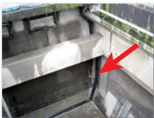
伸縮継手の設置
