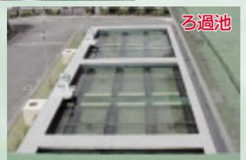
承元寺で取水された水は沈砂池をとおり、谷津浄水場の沈でん池で砂や泥を沈め、急速ろ過されます。
