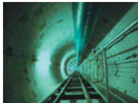
トンネル内部
