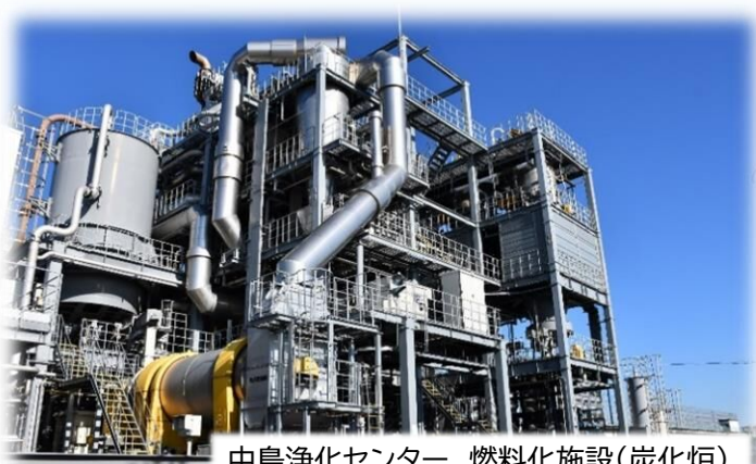
中島浄化センター 燃料化施設(炭化炉)
