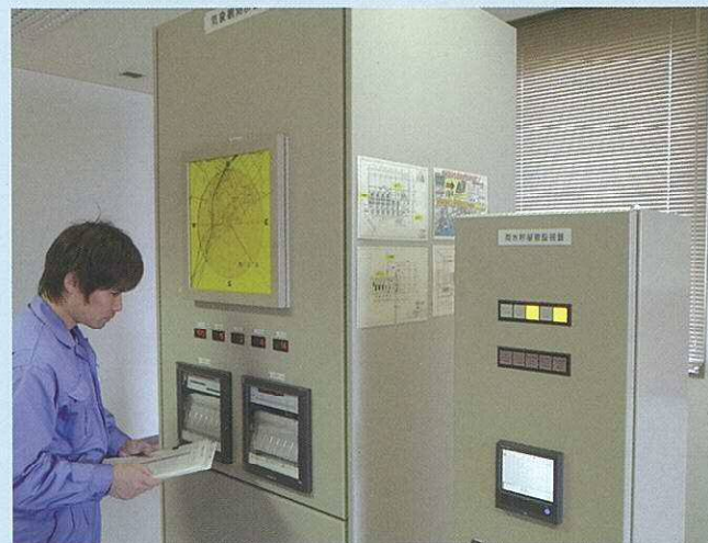
貯留管内部の水位を観測し、ポンプの稼働状況を確認出来る。
