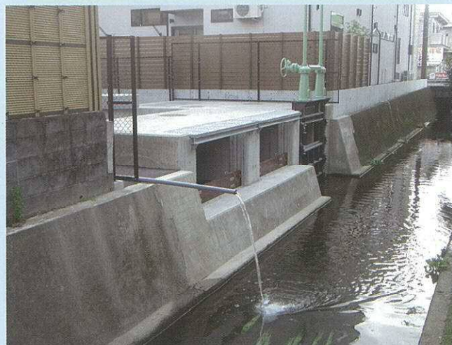
降雨時に増水した水は、取水施設から取り込まれ、貯留管内部へ流れ込む。
