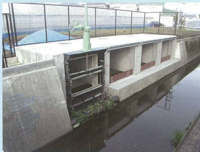
降雨時に増水した水は、取水施設から取り込まれ、貯留管内部へ流れ込む。
