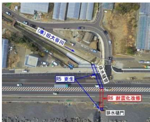
(準)旧大谷川排水樋管耐震化予定地
