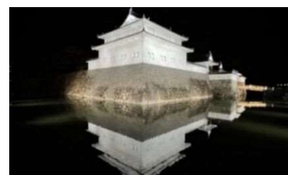
照明整備の事例 (令和4年度 東御門・巽櫓等)
