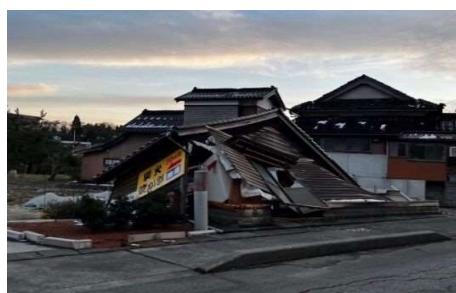
【倒壊した木造住宅】
