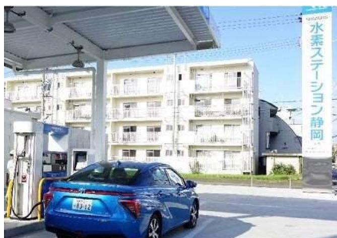
水素ステーション静岡（駿河区曲金二丁目） 平成29年3月竣工
