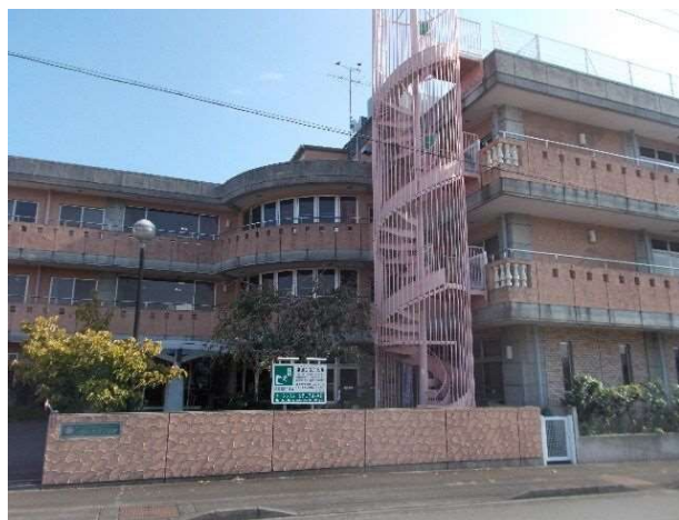
津波避難ビル
