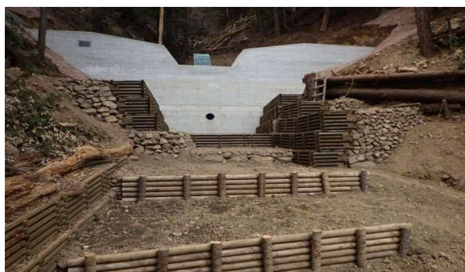
〔コンクリートの谷止工〕
