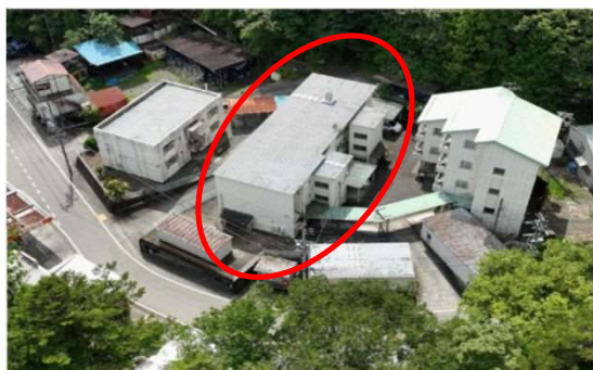
建設予定地(井川教職員住宅B棟跡地)
