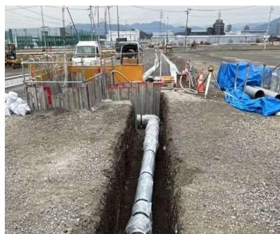
耐震化された水道管への布設替
