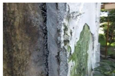
解体後の様子(外壁)
