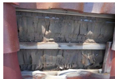
解体後の様子(屋根)
