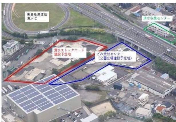
建設予定地の現況
