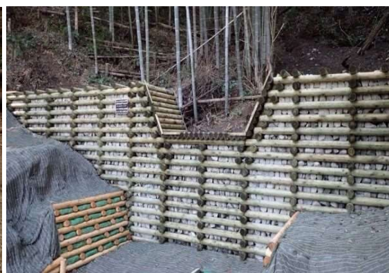
〔木製の谷止工〕
