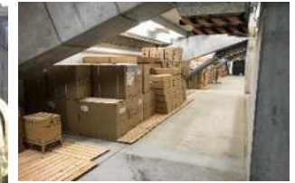
吹田スタジアムの備蓄倉庫 （観客席スタンド下に設置）
