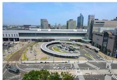
コンパクトなロータリー
