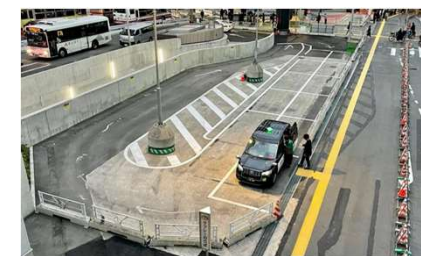
プールの別の場所に設けたタクシー乗り場
