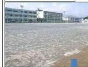
雨水貯留浸透施設
