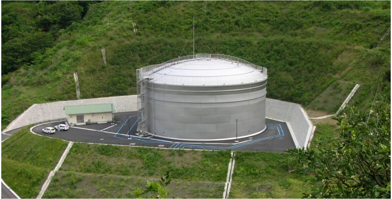
柏尾配水池（令和2年1月北部ルート完成）
