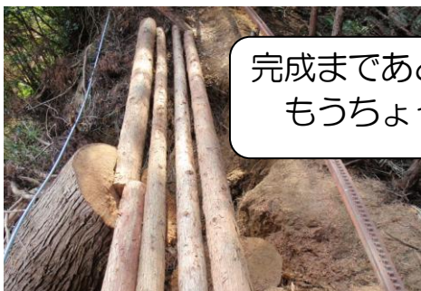
橋の土台を作ります。
