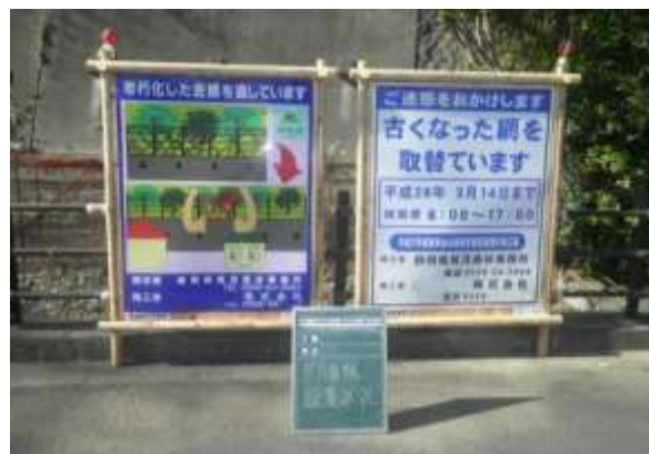
工事PR看板（静岡県）
