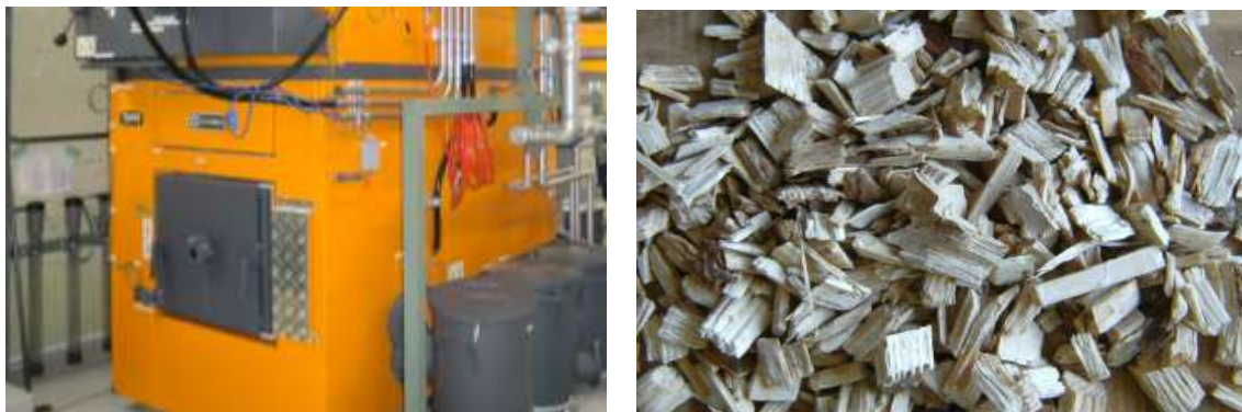
市営温泉「白樺荘」に導入(平成23年度)したバイオマスボイラーと燃料チップ
