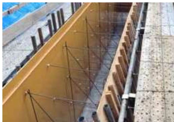
県産材合板型枠（静岡県）
